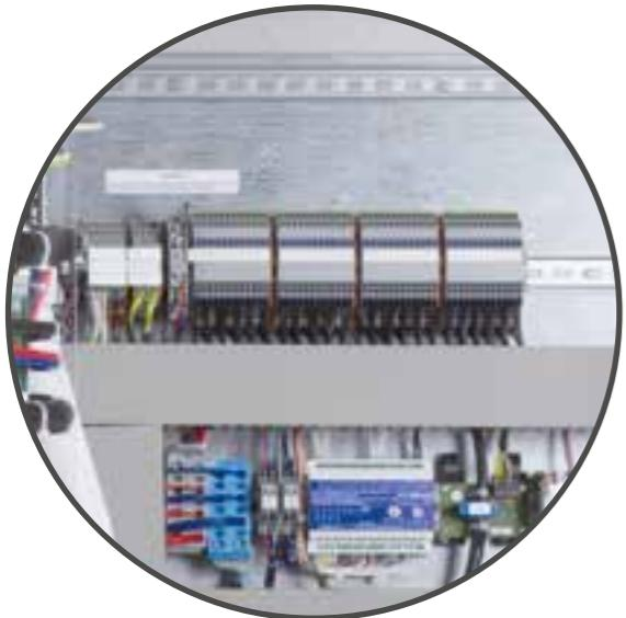
Le champ de raccordement est logé à l'intérieur de l'armoire sur une plaque de montage et sert à raccorder le système à l'alimentation en énergie, vers des éléments externes de message et de commande ainsi qu'à intégrer les circuits de consommateur. Comme le montre l'illustration, le logement du système électronique offre suffisamment de place pour le câblage des lignes de raccordement.
